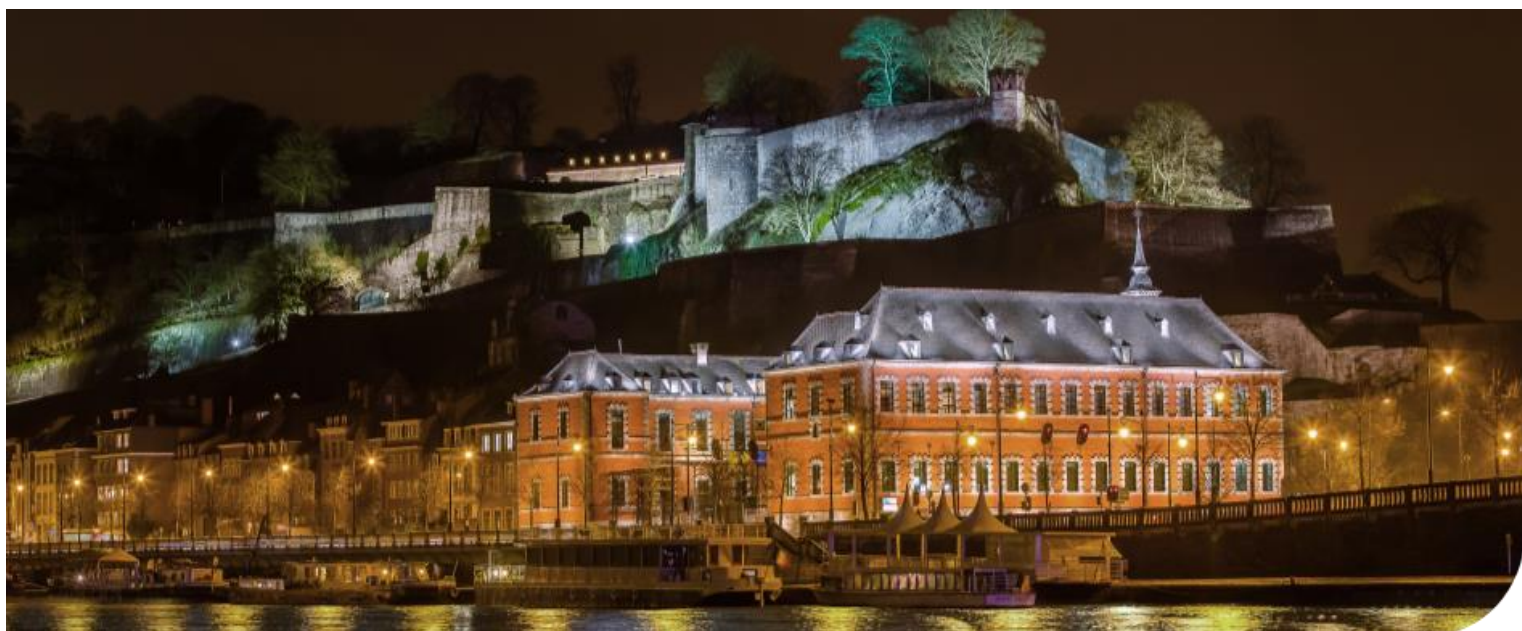
| Chantiers (éclairage) réalisés par l'entreprise Genetec
